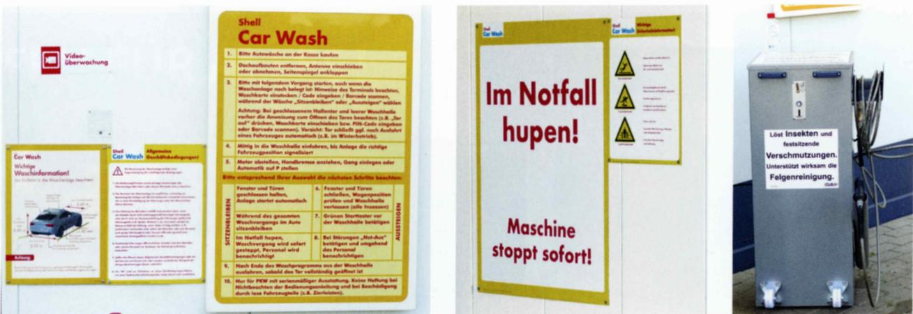
Vorschriftsmäßig: Die Warnhinweise sowie die Anleitung für das Befahren der Waschanlage. Bei Problemen kann der Fahrer durch Hupen die Anlage stoppen. Das fahrbare Christ-Fly-Rex-SB-Vorsprühergerät dient zur Insekten- und Felgenreinigung.
